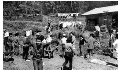
1964年春ロングキャンプ 建設予定地整地
